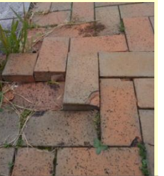
浮き上がった舗装（くりえいと）
